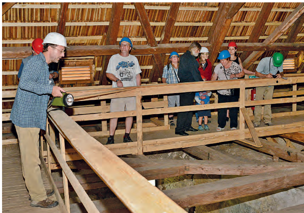
Obr. 70. Odborný výklad v mansardovém krovu donjonu z roku 1720. Účastníci si mohli krov zblízka prohlédnout. Pozorovat bylo možno také právě probíhající údržbu povrchu šindelové krytiny (foto L. Svášková).
