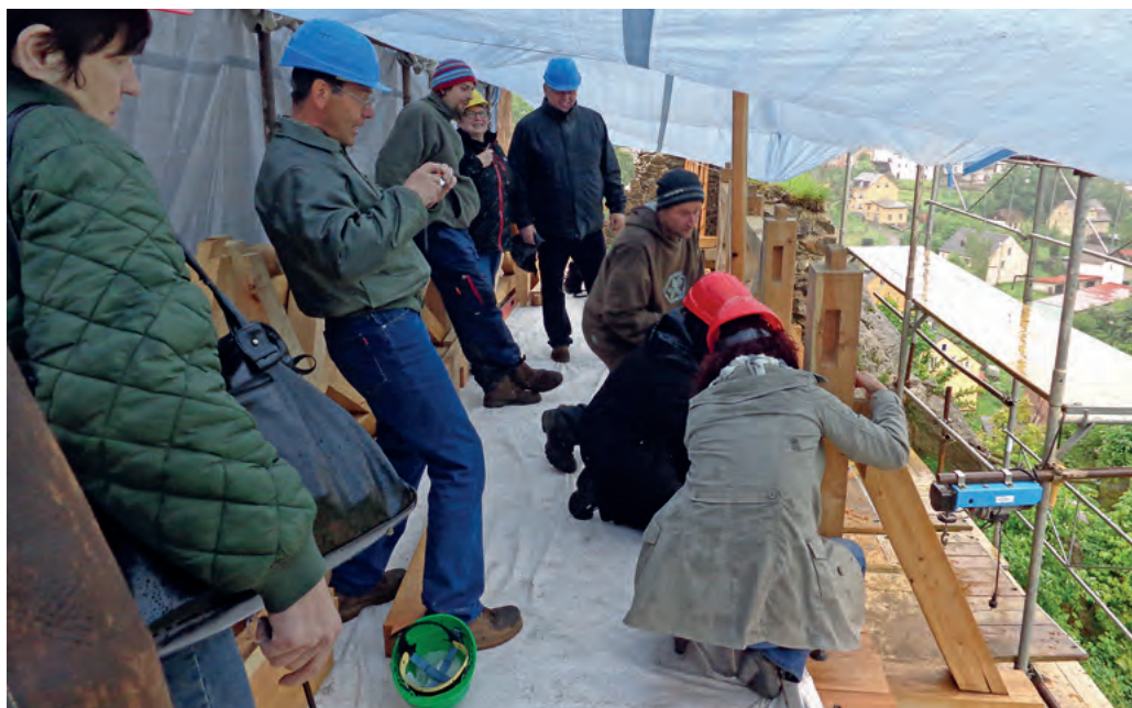
Obr. 66. Při závěrečné tesařské dílně nazvané „Jak se staví most“ se účastníci podíleli na osazení boční konstrukce zábradlí a tím také na celkovém dokončení stavby parkánové lávky u západní paty bečovského donjonu (foto D. Wizovská).
